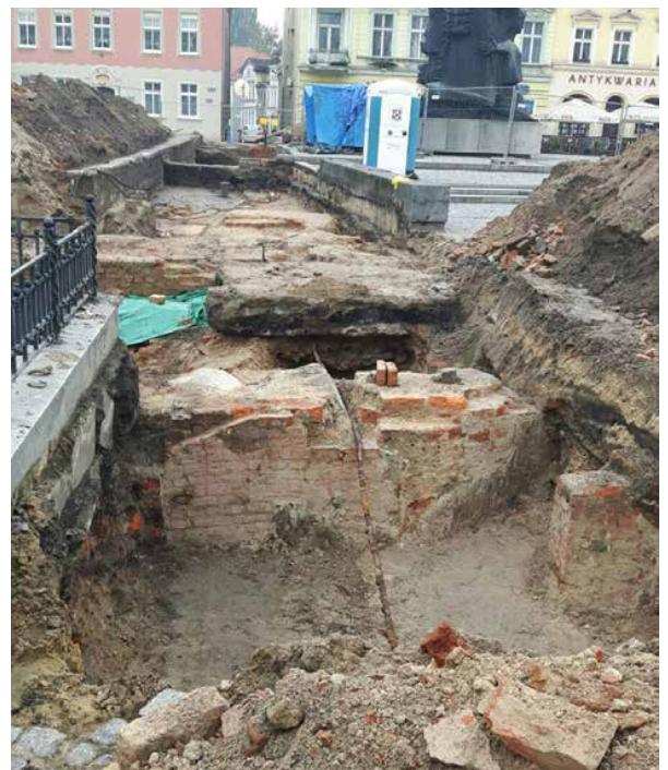
Restos arqueológicos en una obra urbana
